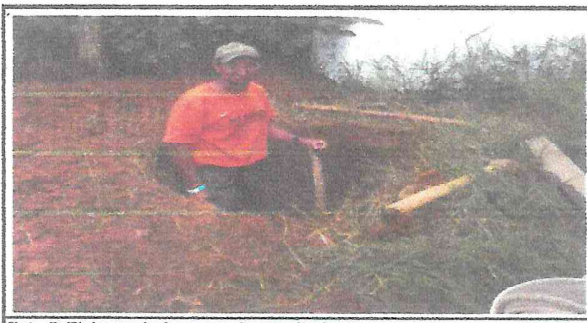
Foto 5: Elaborando fosa para los sanitarios
