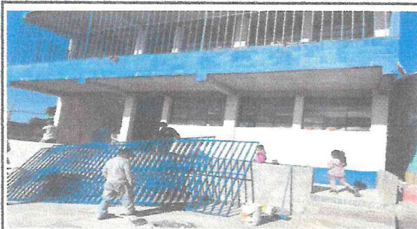
Foto 3: Colocando Barandal en el pasillo inferior
